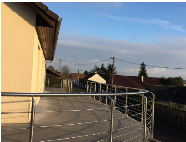
Terrasse et escalier extérieur, garde-corps inox.
